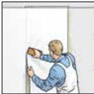
**3.** Die Bahnen Naht an Naht lotrecht verkleben.
