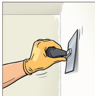
**4.** Die Feinglättung erfolgt, sobald die Oberfläche im Streiflicht den Glanz verliert und matt ist, unter leichtem Druck mit einem flexiblen Glättwerkzeug (z.B. venezianische Glättkelle) in einem Winkel von etwa 5°. Dies ist je nach Temperatur und Luftfeuchtigkeit nach ca. 60 Minuten der Fall.
