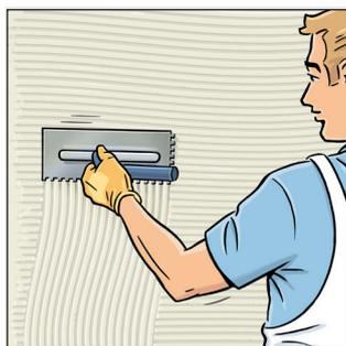
3. Anschließend wird der Grundputz Frisch-in-Frisch mit der Glättkelle vollflächig aufgezogen und anschließend mit einer C4-Zahnung (8 x 8 mm) im Kreuzgang durchgezahnt und das überschüssige Material entfernt. Dabei ist darauf zu achten, dass die zweite Zahnung parallel zur Hauptlichteinfallrichtung verläuft.
