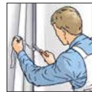
**5.** In Ecken und an Kanten wird nicht überlappend tapeziert, sondern die Trennung erfolgt exakt auf der Kante und nachfolgende Bahn auf Stoß tapezieren.
