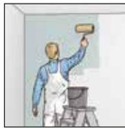
**2a.** Bahnen in erforderlicher Länge unter Zugabe von 5 - 10 cm zuschneiden. Kleister nach Herstellerangaben anrühren und Vlies-Tapete
