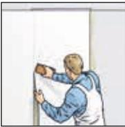
3.墙纸卷并排垂直铺贴。用裱糊刷或橡胶辊将墙纸刮平并挤出气泡。
