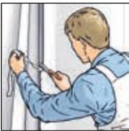
6.在墙角和边缘处，将墙纸卷切开将之后的墙纸卷并排铺贴好。
