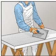
4. Appliquer la colle sur l'ensemble de la cale d'isolation à l'aide d'une spatule crantée ou d'une truelle crantée (dentelure de 8 mm minimum).
