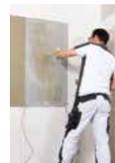
3. Kleber drückt sich durch das perforierte Vlies.
