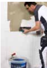
1. Kleber mit Zahnschachtel aufziehen.
