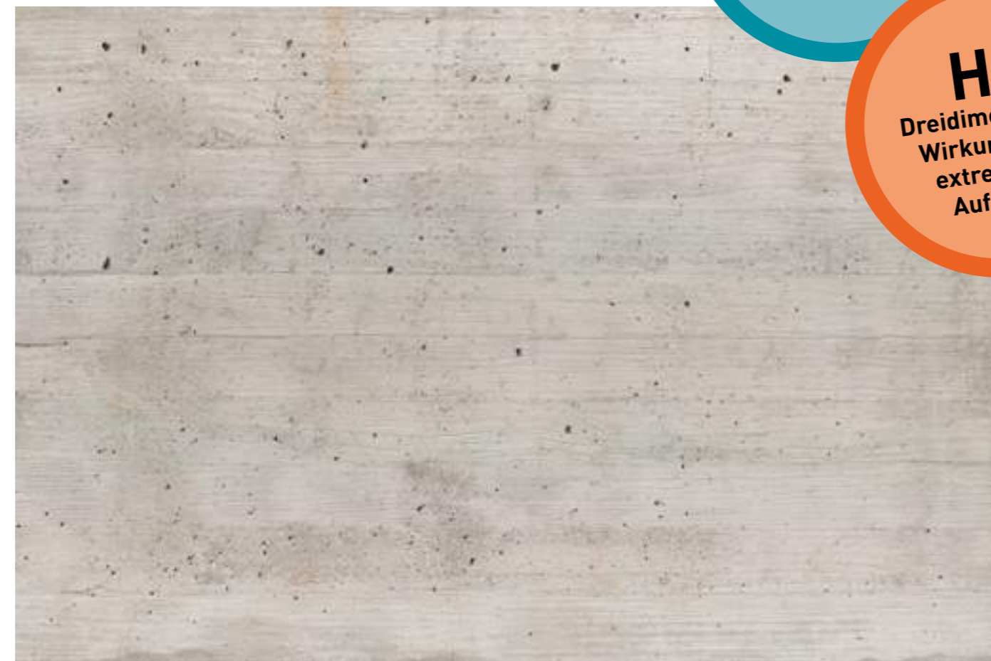
Sichtbeton Lunker | 463
