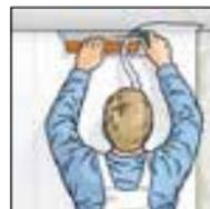
6. Überstehendes Variovlies an der Decke und dem Boden mit einem Cuttermesser oder einer Hakenklinge mittels eines Spachtels oder einer Schneideschiene sauber abtrennen.
