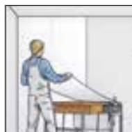
**2b.** im Kleistergerät ohne Weichzeit. Zur Verklebung Vlieskleber verwenden.
