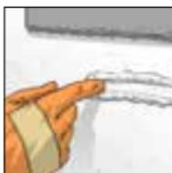
3. Dispersionskleber satt mit einer langflorigen Walze bahnenweise (siehe Fingertest) auf alle glatt bis mittel strukturierten Untergründe aufrollen.
