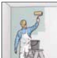
2. Der Untergrund muss sauber, trocken sowie trag- und saugfähig sein. Nicht tragfähige Untergründe vorher entfernen.
