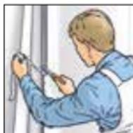
5. Überstehende Außencken mit einem Cuttermesser oder einer Hakenklinge sauber abschneiden. Zur optischen Stabilisierung der Außencken, empfiehlt sich das Anbringen von Kunststoffckeleisten auf dem Variovlies.
