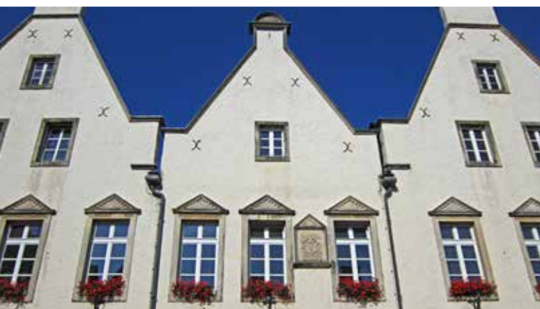
Budynki z brakującym występem dachowym | Tetőkiugrás nélküli épületek
