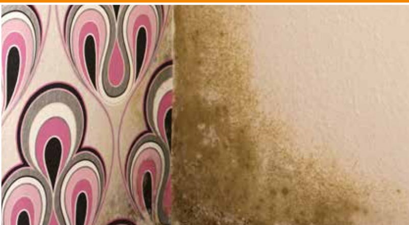
Zaatakowanie powierzchni przez pleśń | Penészesedés
