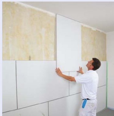
So passt es: Die Platten werden senkrecht angeordnet und verlegt.
