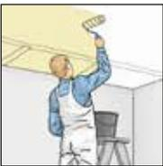
**7.** Dämmkeile und Decke mit Kleister grundieren
