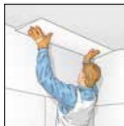
**5.** Dämmkeile nebeneinander mit mäßigem Druck an Wand bzw. Decke anpressen. Überschüssigen Kleber an den Rändern entfernen.
