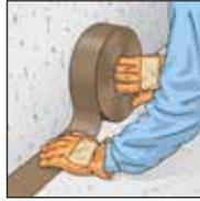
**2.** Entkopplungsband zur akustischen und mechanischen Entkopplung umlaufend an Boden, Decke und einbindenden Wänden sowie an allen beweglichen Bauteilen, z. B. Fenster, anbringen.
