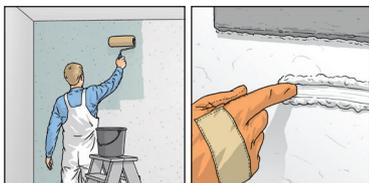
2a. Nous recommandons une pose par la technique d'encollage mural sans détrempe. Appliquer la colle généreusement et uniformément à l'aide d'un rouleau à longs poils (cf. test du doigt).
