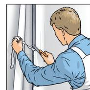
6. Ne pas effectuer de chevauchement dans les coins et sur les arêtes. La séparation se fait exactement sur l'arête. Poser les deux lés bord à bord à joints vifs.
