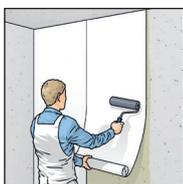
4. Éliminer les bulles d'air et les plis à l'aide d'un rouleau en caoutchouc ou d'une brosse à tapisser. N'utiliser en aucun cas la roulette de tapissier !
